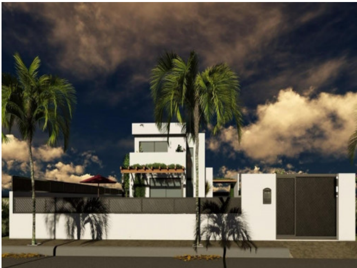
Vistas desde la calle
