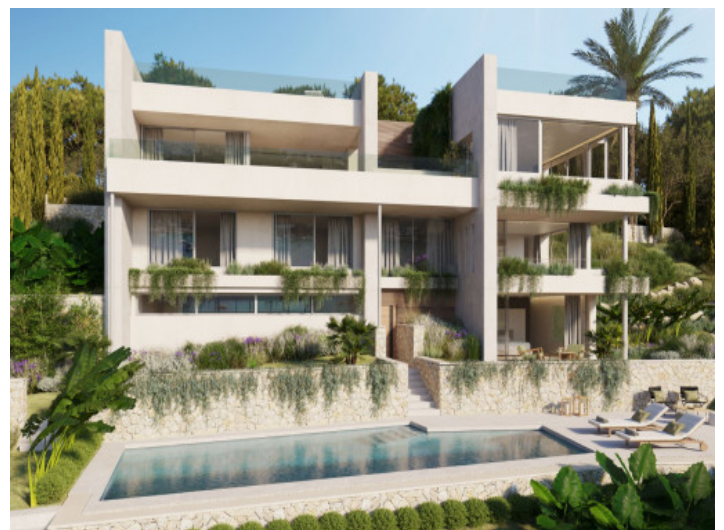
Fachada y piscina
