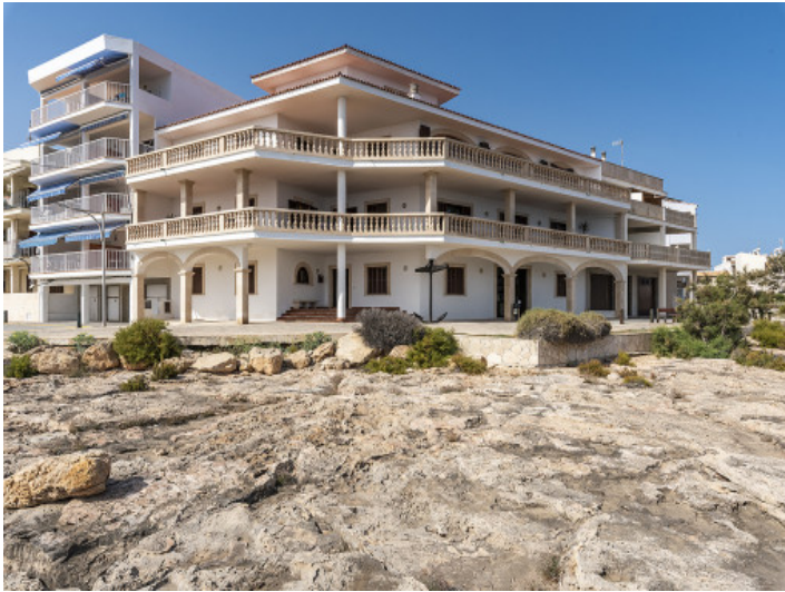
Vista exterior de la casa
