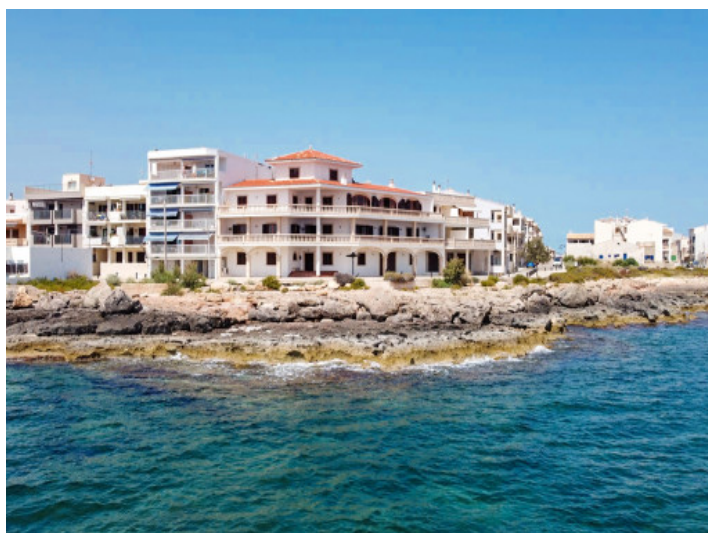
La casa a vista exterior
