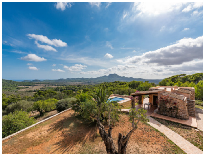
Vista a la casita de huéspedes
