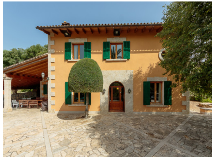
Fachada de la finca
